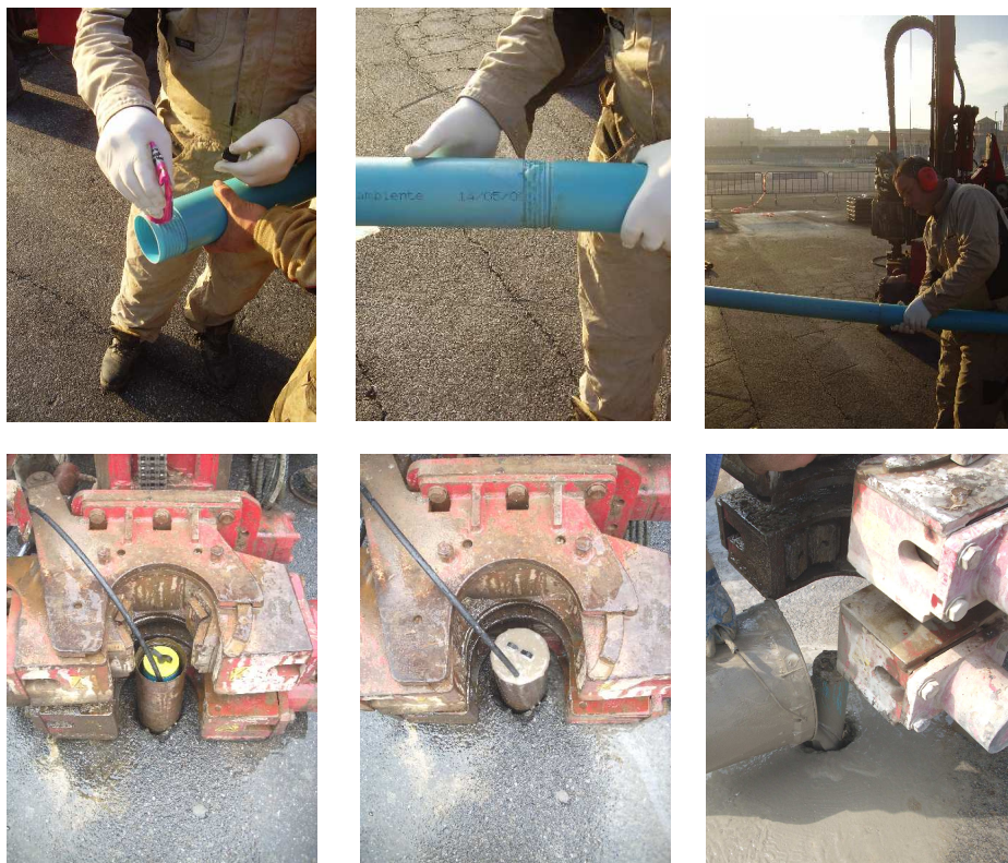
Figura 11: alcune fasi dell'installazione dei tubi in PVC per l'esecuzione di sismica in foro
